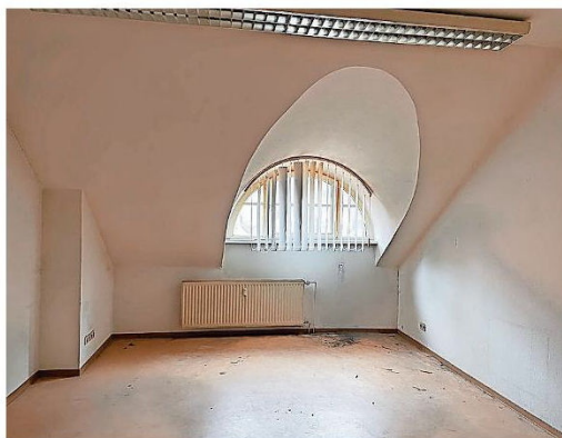
Ehemaliges Büro im Dachgeschoss der Landratsvilla in Bad Freienwalde: Der Umbau zu Hotelzimmern ist dem Investor untersagt worden. Foto: Ulf Grieger
